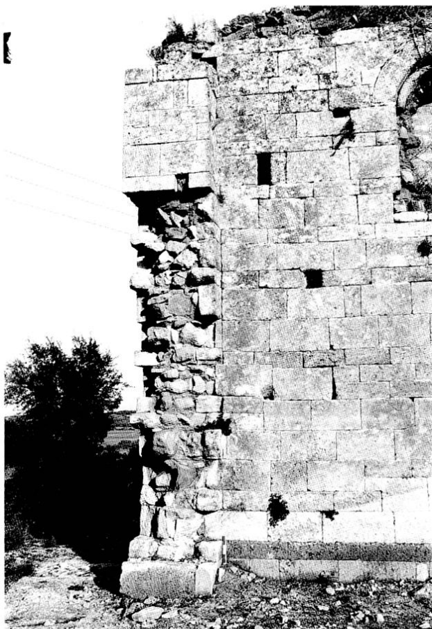
Fig. 26 : Contrefort de l'angle sud-ouest montrant la disposition interne de l'appareil alterné ainsi que le remplissage du mur.
