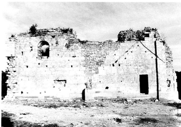
Fig. 6 : Vue générale côté sud.
