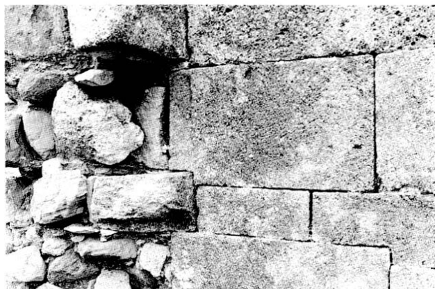
Fig. 27 : Détail de la liaison du mur sud avec le contrefort de l'angle sud-ouest, montrant la feuillure taillée sur une pierre du mur (pierre centrale à gauche), afin de pouvoir l'engager dans le contrefort déjà construit.
