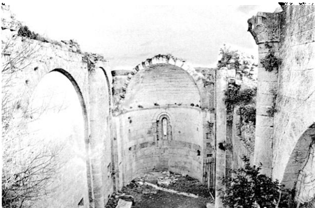
Fig. 10 : Vue générale intérieure d'ouest en est.
