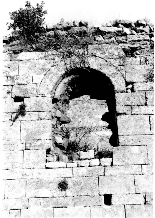
Fig. 16 : Baie méridionale vue de l'extérieur.
