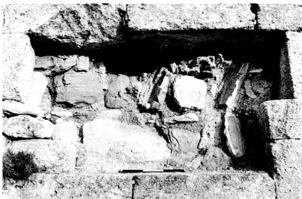
Fig. 18 : Vue du remplissage des murs composé de pierres de tout-venant liées avec un mortier de chaux très graveleux.
