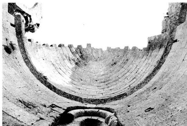
Fig. 32 : Voûte en cul de four de l'abside vue de dessous.
