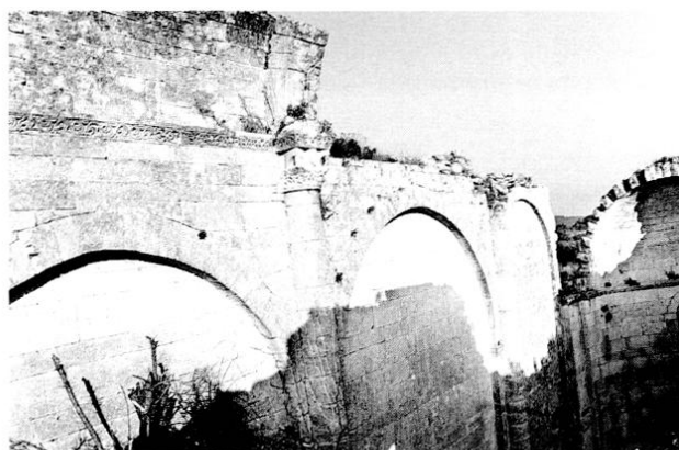
Fig. 24 : Vue intérieure du mur nord montrant (à gauche) la différence de ton entre les assises étroites posées dans leurs lits, plus foncées et les assises hautes en délit, plus claires. Les arcs sont légèrement brisés.
