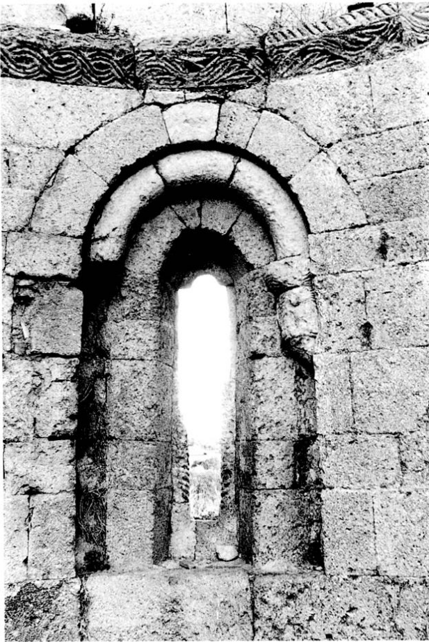
Fig. 15 : Baie axiale vue de l'intérieur.
