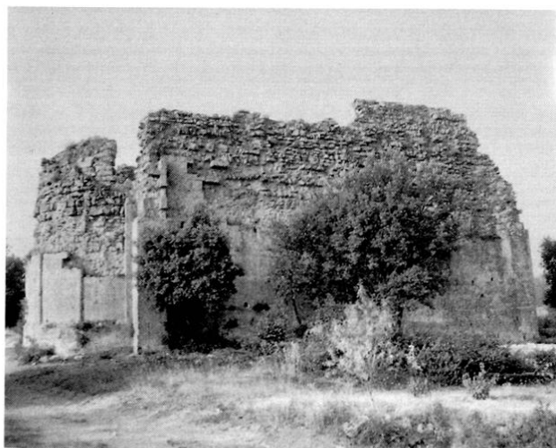
Fig. 7 : Vue générale côté nord.
