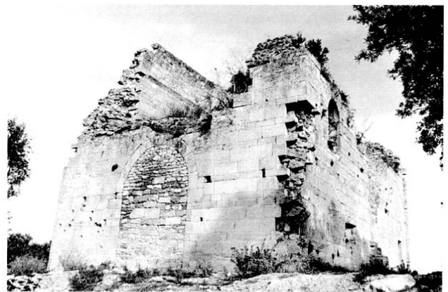
Fig. 8 : Vue générale de la façade occidentale.
