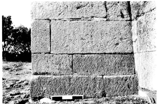
Fig. 11 : Exemple de la taille ciselée en séries verticales de chevrons sur le parement mis au jour récemment à la base du contrefort sud-est. On remarque sur le joint supérieur un calage de pierre dure.
